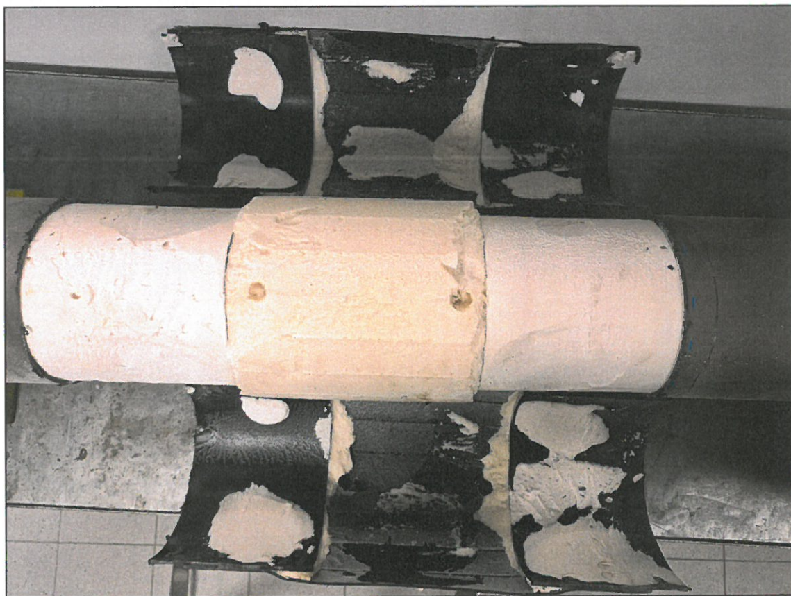
Fot. 35, 36 Obiekt LB/81/2023 po badaniu wodoszczelności
